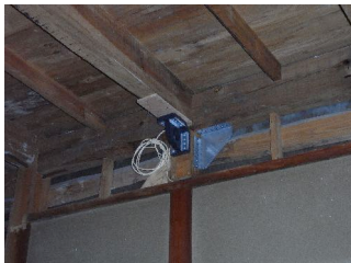
木造住宅の天井裏設置事例
