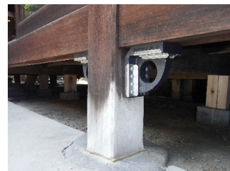
寺院改修の床下設置事例
