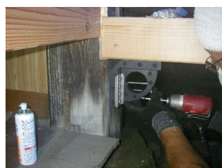
木造住宅の床下施工
