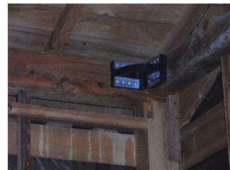
木造住宅2階床面（水平）への施工
