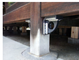
寺院改修の床下設置事例
