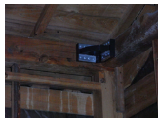
木造住宅天井面（水平）への施工
