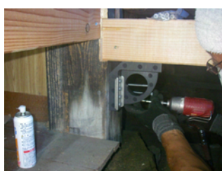
木造住宅の床下施工
