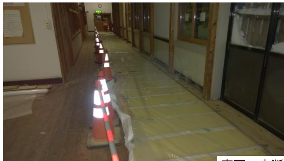
廊下の床断熱・床板復旧工事
