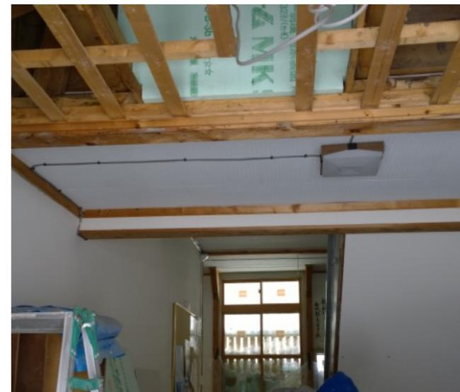
《第2期工事》本棟（南側内部）耐震補強・断熱工事（2016年3月）完了
